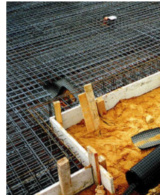
Noppenbahn als Sauberkeitsschicht
