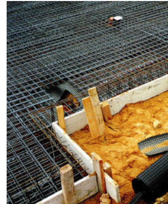
Noppenbahn als Sauberkeitsschicht
